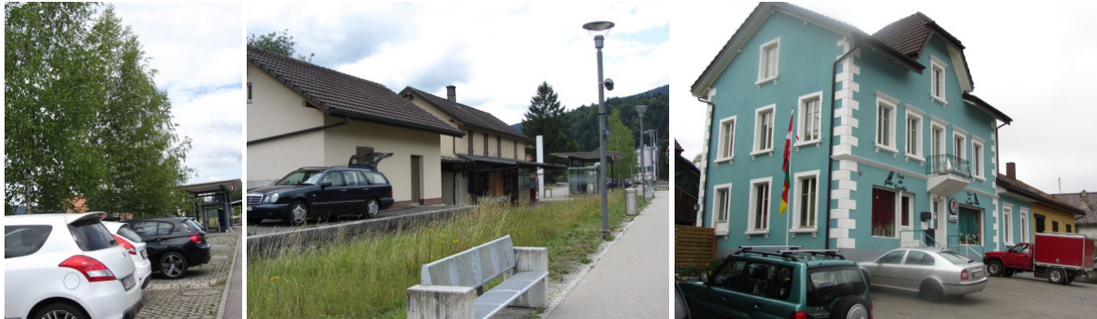
iii. 89 - 91 : un espace dissout dans une confusion des usages, eux-mêmes distraits par l'absence d'une vision d'ensemble et partagée par tous les intervenants (propriétaires)
