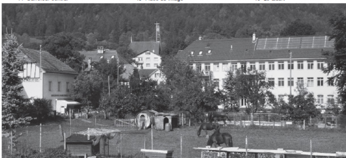
17 Ancienne fabrique de montres Cortébert Watch, 1865/73
