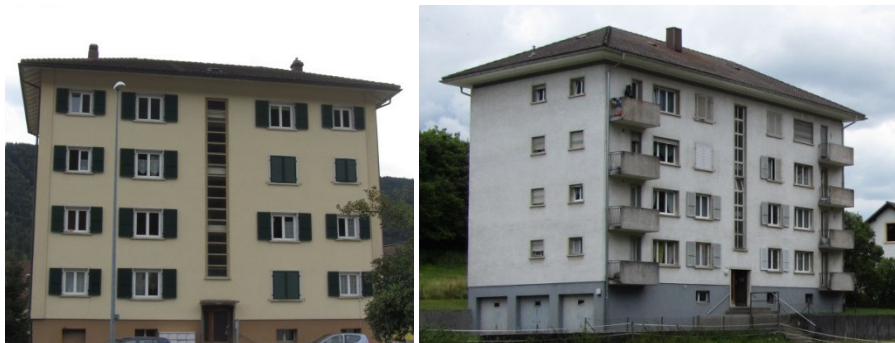
ill. 86 et 87 : architecture : preuves locales, s’il le fallait, que mêmes des bâtiments de type ‘locatif’ s’apprêtent parfaitement à être couverts d’une toiture ‘classique’
